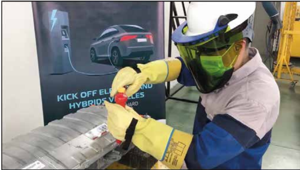
Figura 4. Uso de equipo de protección personal al intervenir la batería de tracción
