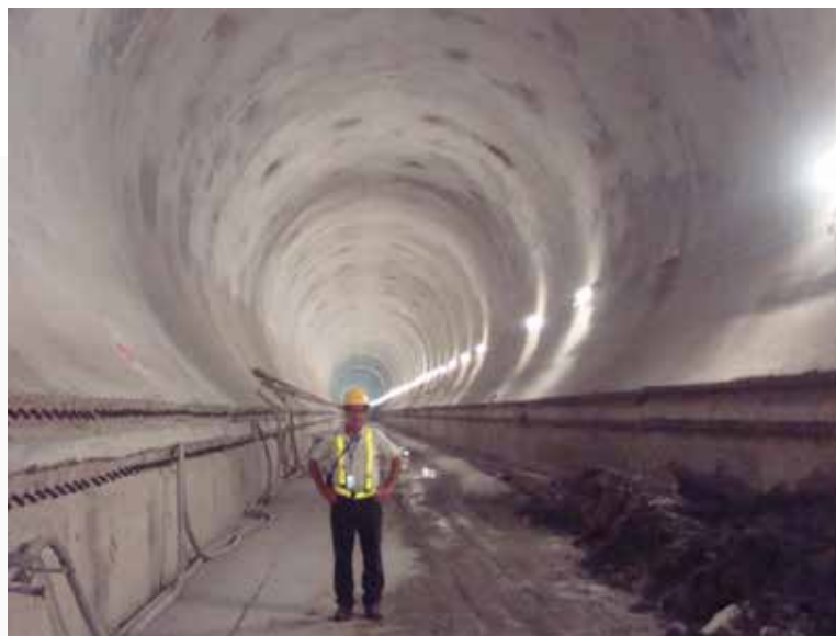
TUNEL DE CONDUCCIÓN PH Reventazón de 9.2 metros de diámetro
