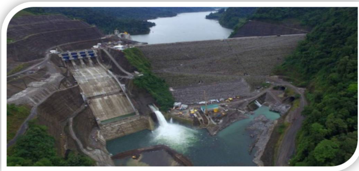
Fotografía aérea de la presa, del vertedero de excedencias, la toma de agua, descarga de fondo, tubería forzada, la casa de máquinas en la central de compensación ambiental.
